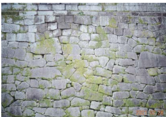
図168 私学校跡に面した堀の石垣
