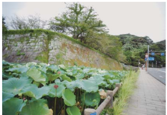
図14 城壁の北東の角の隈欠。歩道の先は、薩摩義士の碑。その手前の小さい橋が北門の橋。その奥に城山が迫る。
